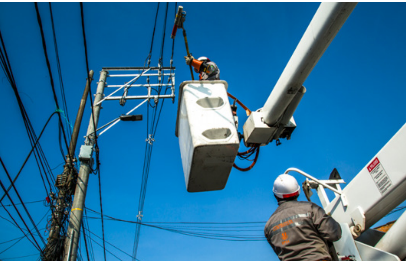
Operarios trabajan en el mantenimiento de las redes y postes de energía.
