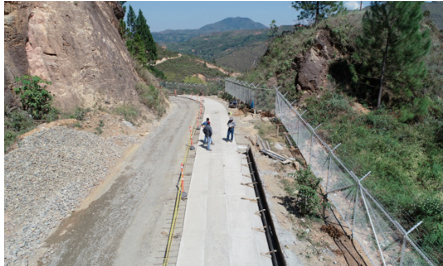
En Suárez, Cauca, construimos una placa-huella a través del mecanismo Obras por Impuestos. Beneficiará a más de 5.000 personas.
