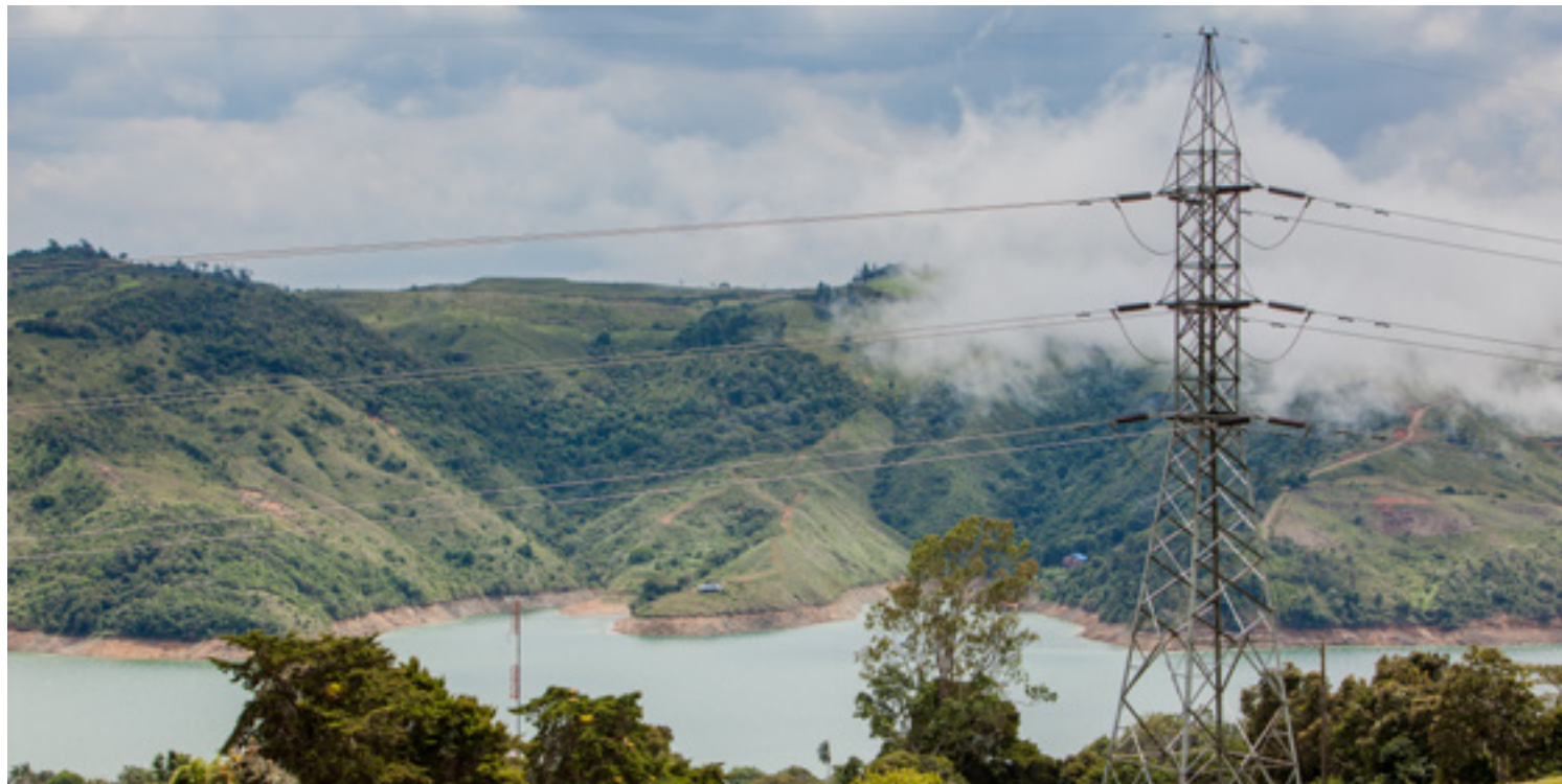
Sistema de distribución eléctrica en el Valle del Cauca.
