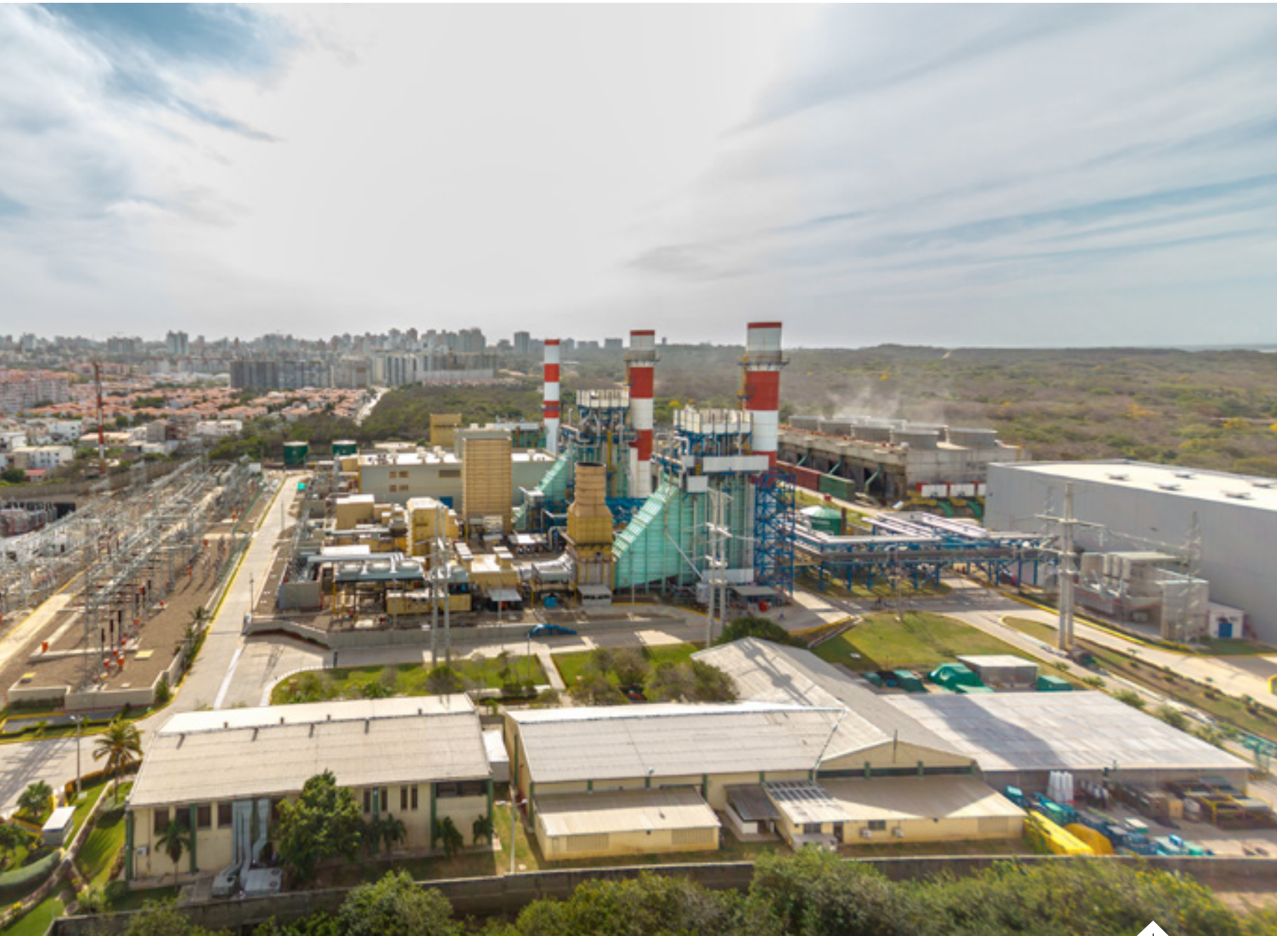
Central térmica Zona Franca Celsia, Barranquilla, Colombia.
