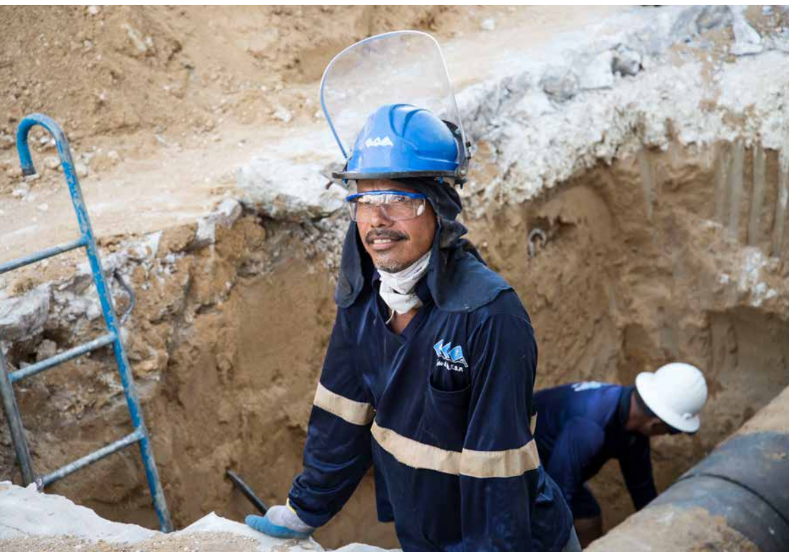
Nuestra fuerza operativa trabaja para reducir fugas y realiza mantenimientos para minimizar los daños en las redes de acueducto.
