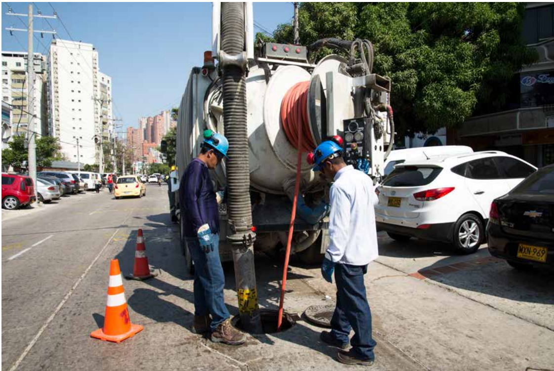
El camión succión-presión hace parte de los procesos tecnológicos de alcantarillado para la limpieza general de la infraestructura de este servicio.
