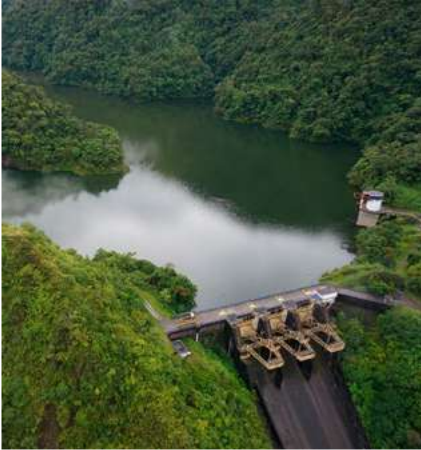
Central Hidroeléctrica Alto Anchicayá, Valle del Cauca, Colombia.
