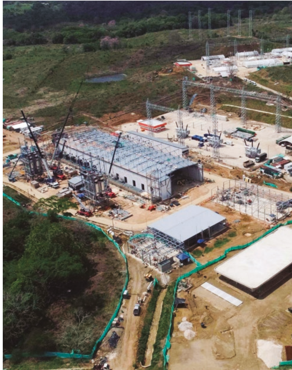
La termoeléctrica El Tesorito que construimos en el corregimiento de San Antonio en Sahagún, Córdoba, avanza en más del 70% y comenzará a operar este año.
