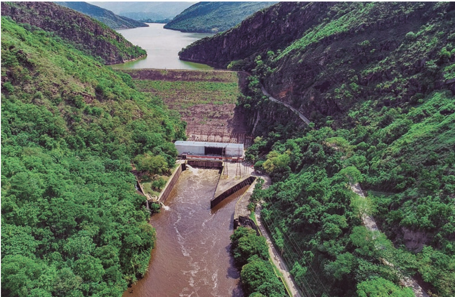
Central hidroeléctrica Prado, ubicada en el departamento del Tolima.
